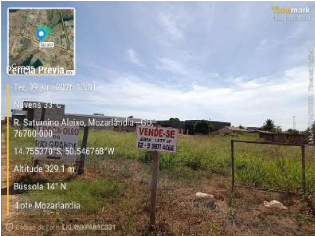
Foto 200 — Lote/área do grupo com placa — Mozarlândia/GO. (registro da diligência, 09/06/2026).
