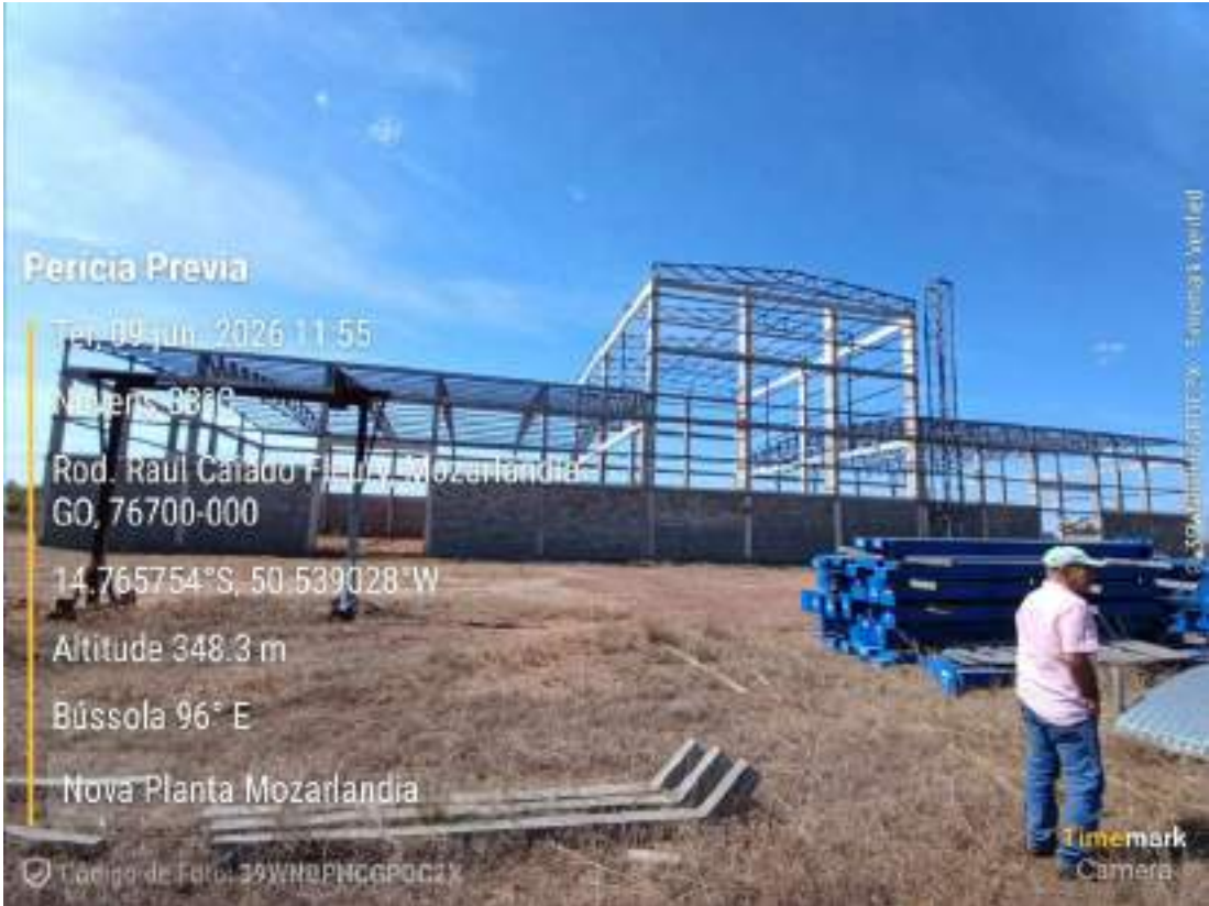
Foto 186 — Estrutura metálica do galpão industrial em montagem — Nova Planta de Mozarlândia/GO. (registro da diligência, 09/06/2026).
