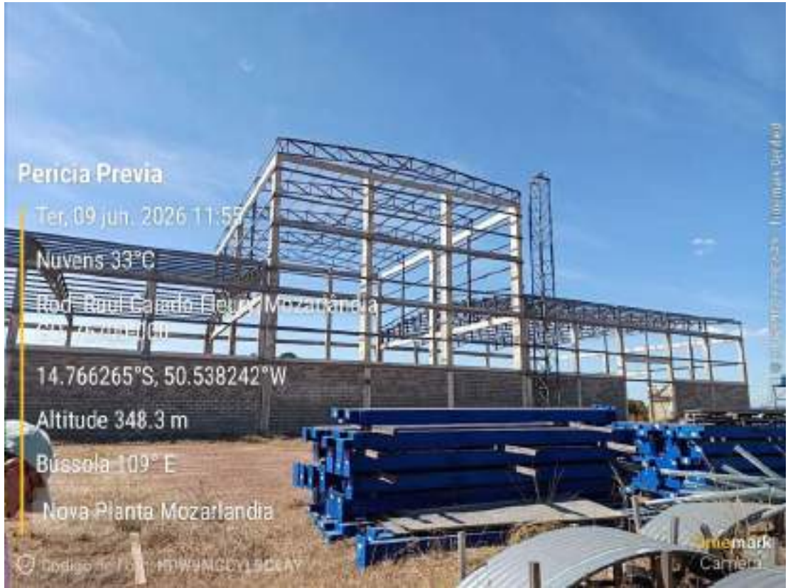
Foto 192 — Estrutura metálica em montagem — Nova Planta de Mozarlândia/GO. (registro da diligência, 09/06/2026).
