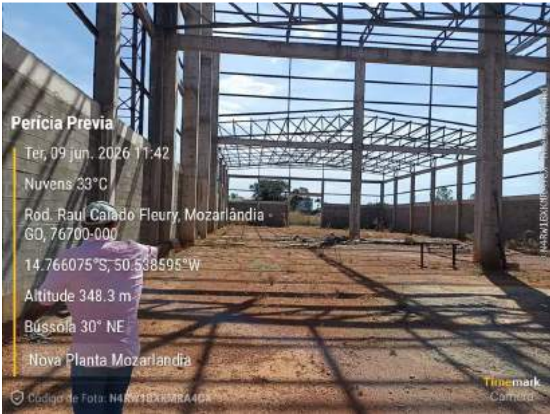
Foto 196 — Estrutura metálica do galpão — Nova Planta de Mozarlândia/GO. (registro da diligência, 09/06/2026).
