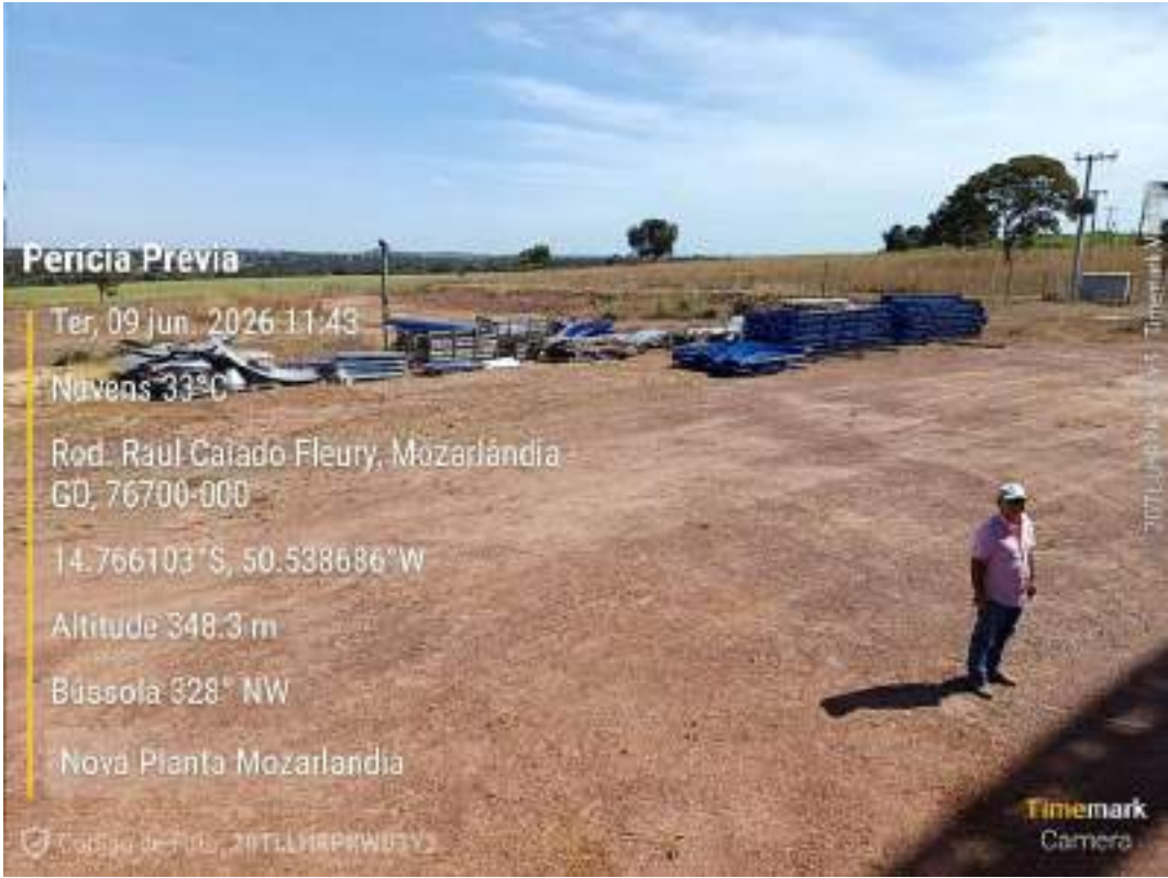
Foto 187 — Canteiro de obras — Rod. Raul Caiado Fleury, Nova Planta de Mozarlândia/GO. (registro da diligência, 09/06/2026).
