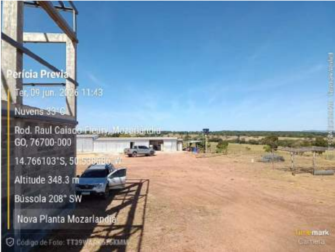
Foto 193 — Canteiro com materiais de construção — Rod. Raul Caiado Fleury, Nova Planta de Mozarlândia/GO. (registro da diligência, 09/06/2026).
