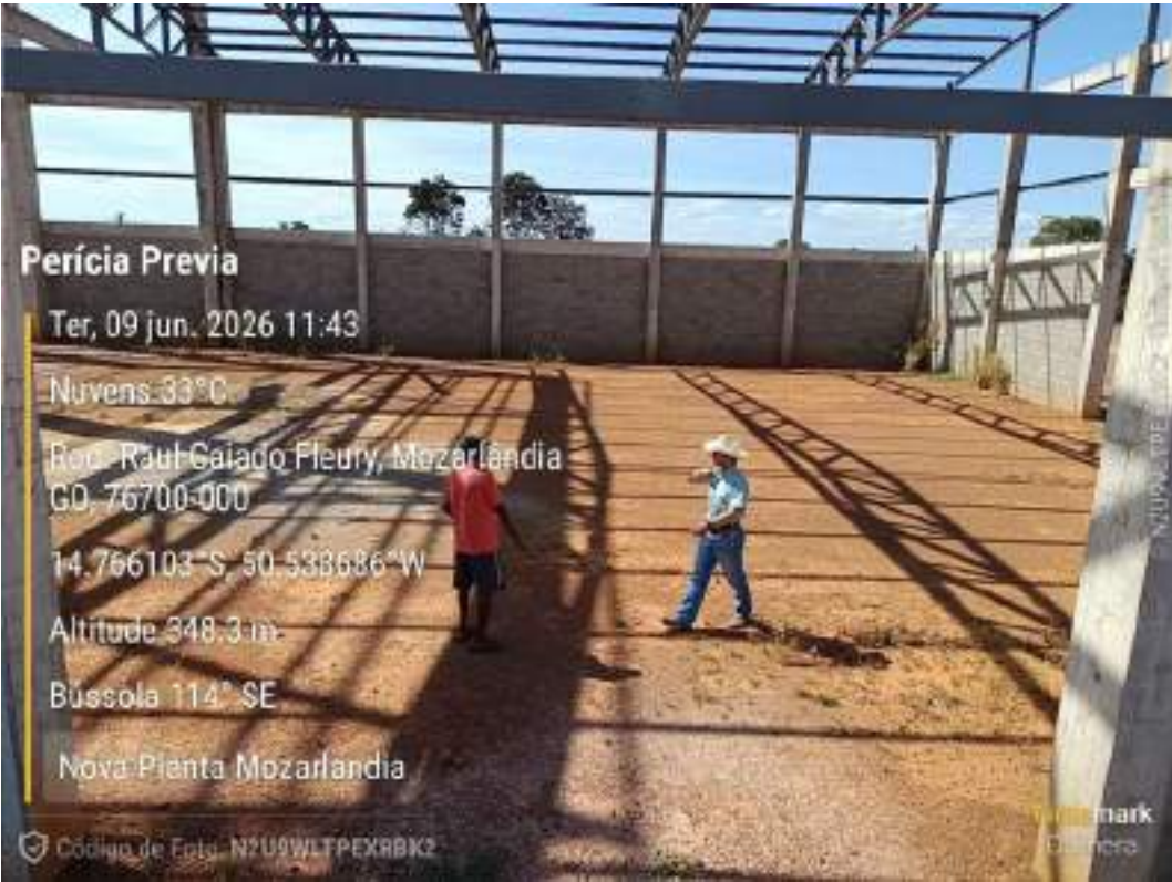
Foto 190 — Interior do galpão em construção — Nova Planta de Mozarlândia/GO. (registro da diligência, 09/06/2026).
