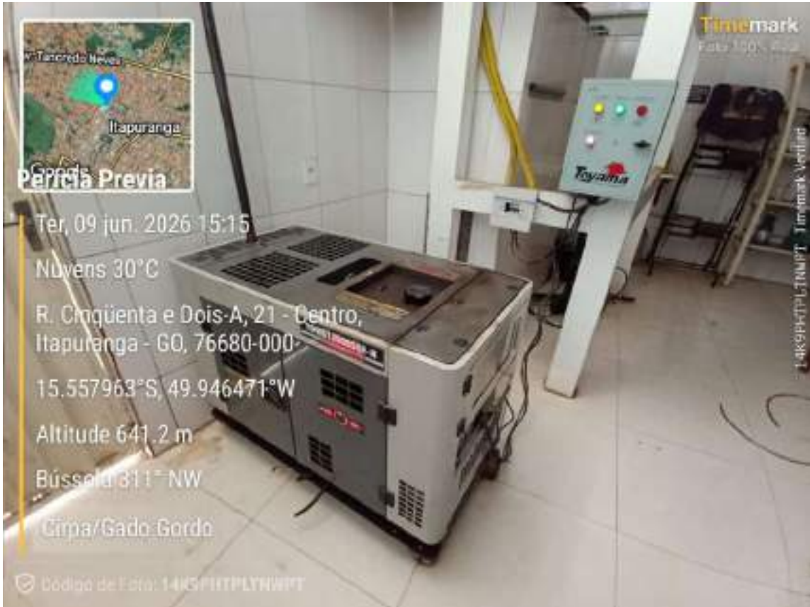
Foto g2 — Copa/área de serviço — sede CIRPA/Gado Gordo, Itapuranga/GO. (registro da diligência, 09/06/2026).
