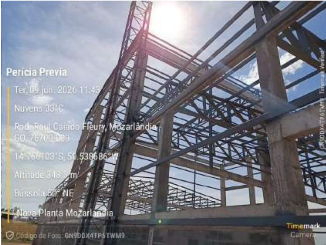
Foto 195 — Estrutura metálica em montagem — Nova Planta de Mozarlândia/GO. (registro da diligência, 09/06/2026).
