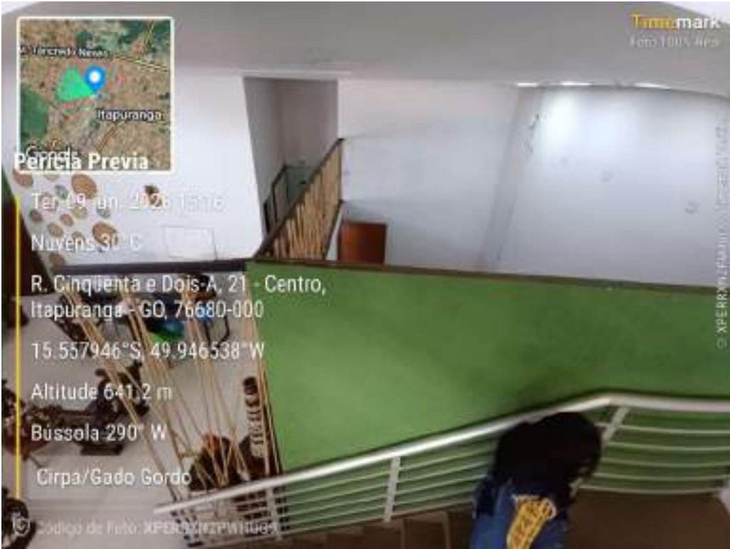
Foto 85 — Escada/pavimento superior interno — sede CIRPA/Gado Gordo, Itapuranga/GO. (registro da diligência, 09/06/2026).
