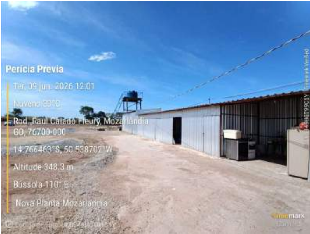
Foto 188 — Galpão e pátio da obra — Nova Planta de Mozarlândia/GO. (registro da diligência, 09/06/2026).
