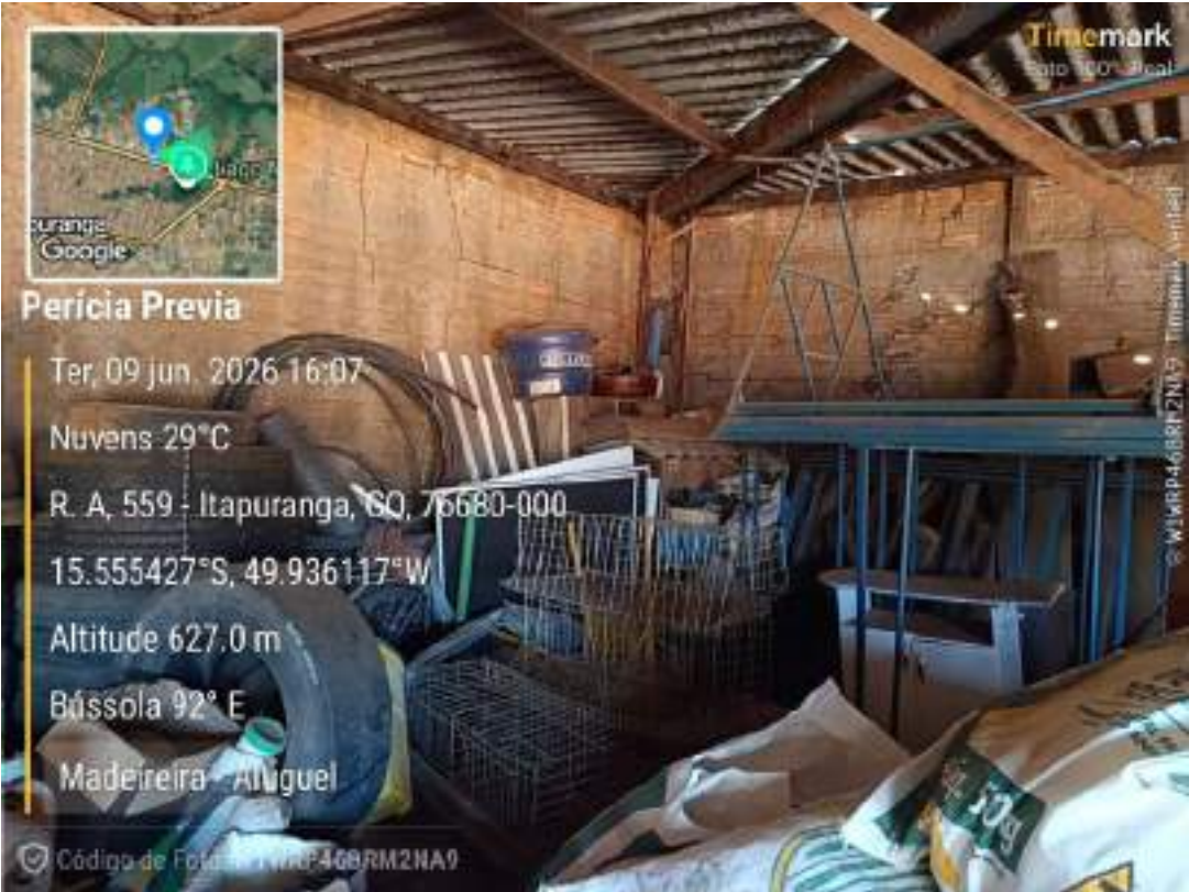
Foto 155 — Interior do galpão da Madeira de Lei (estruturas de madeira) — R. A, nº 559, Itapuranga/GO. (registro da diligência, 09/06/2026).
