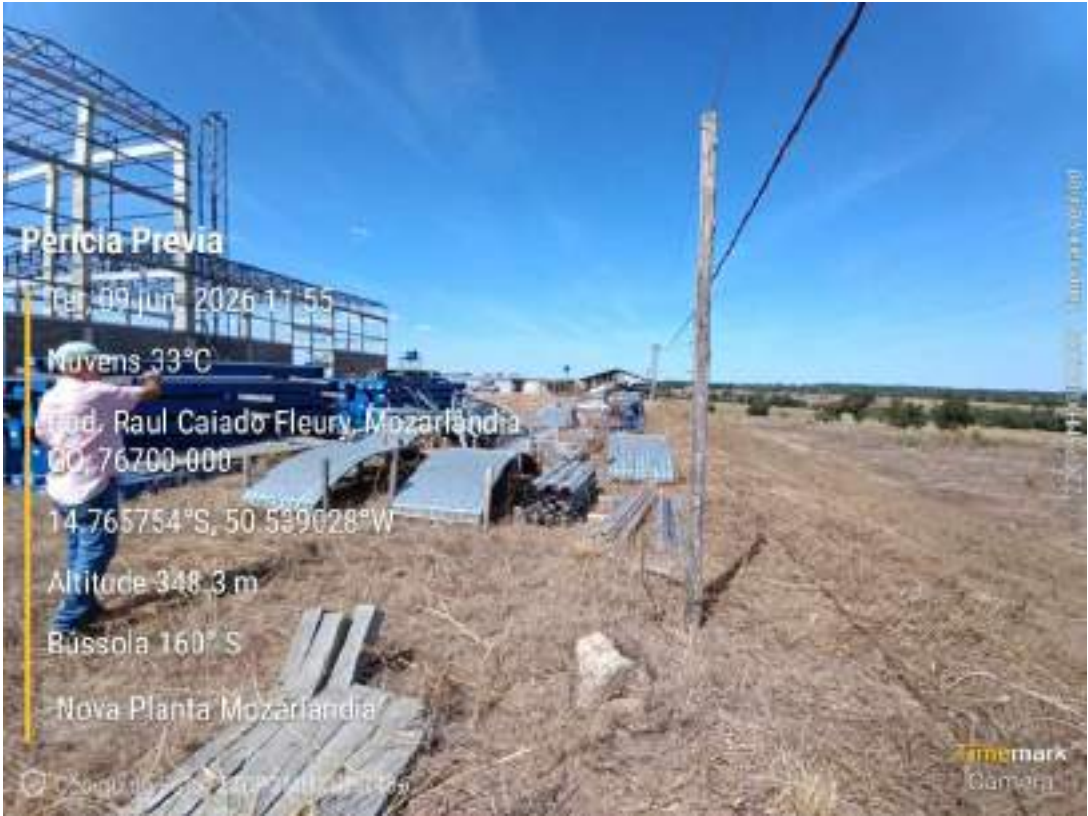
Foto 185 — Estrutura metálica do galpão em montagem — Nova Planta de Mozarlândia/GO. (registro da diligência, 09/06/2026).
