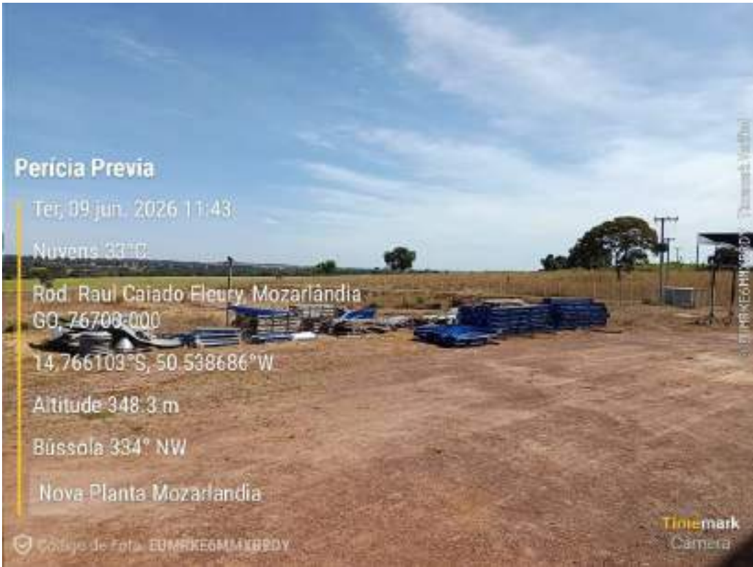
Foto 198 — Vista do canteiro de obras — Nova Planta de Mozarlândia/GO. (registro da diligência, 09/06/2026).
