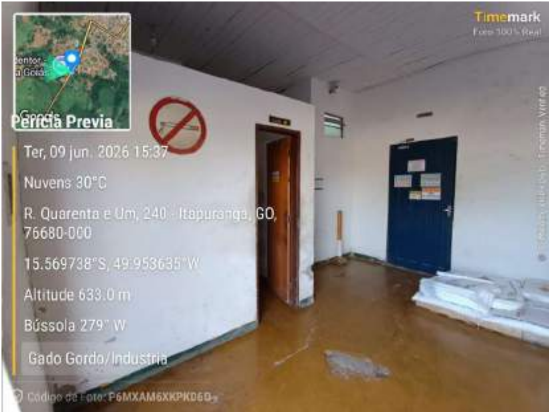
Foto 148 — Acesso interno — Gado Gordo Indústria, Itapuranga/GO. (registro da diligência, 09/06/2026).
