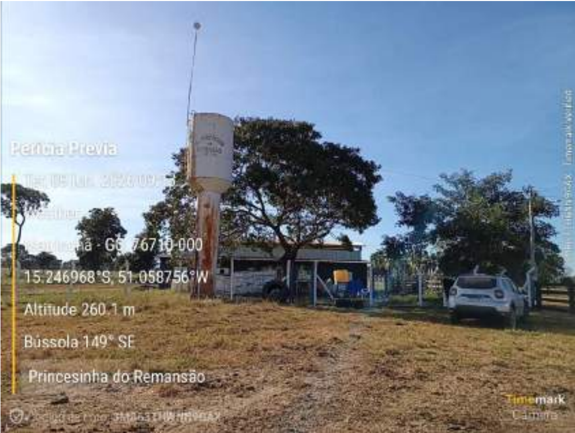
Foto 63 — Benfeitorias e reservatório — Fazenda Princesinha do Remansão. (registro da diligência, 09/06/2026).
