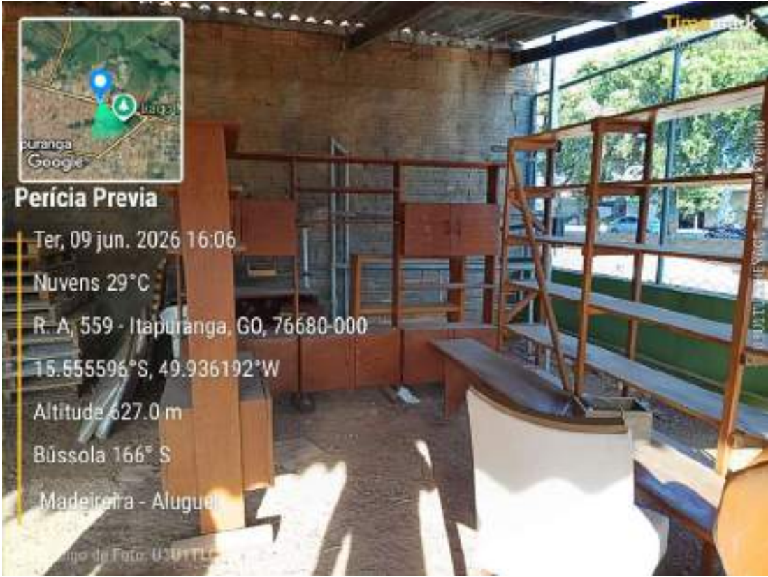
Foto 163 — Estrutura/galpão de madeira — Madeira de Lei, Itapuranga/GO. (registro da diligência, 09/06/2026).
