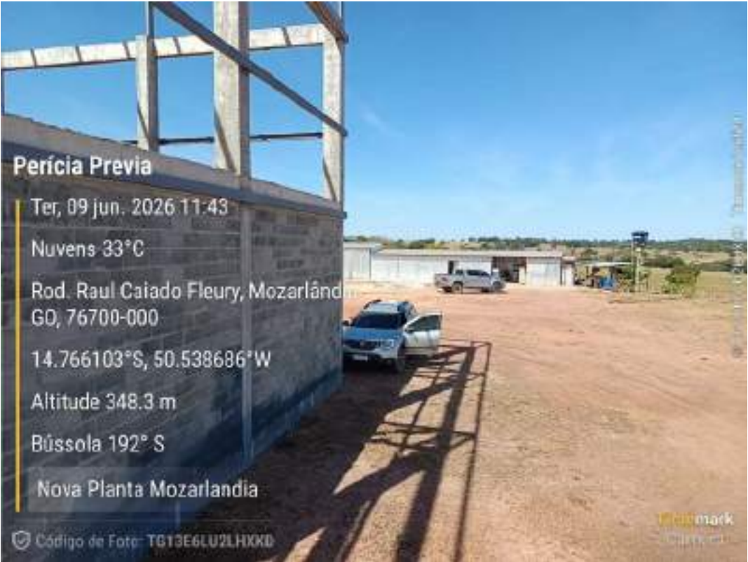
Foto 197 — Estrutura metálica e veículo no canteiro — Nova Planta de Mozarlândia/GO. (registro da diligência, 09/06/2026).
