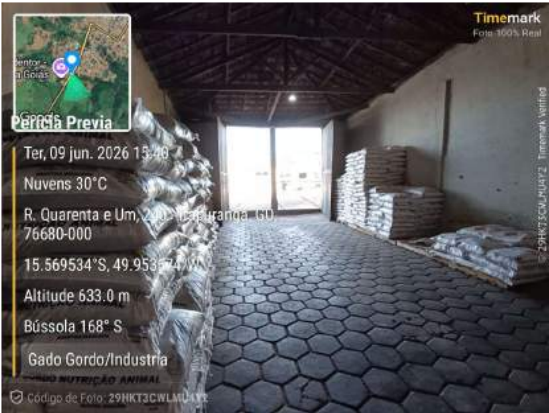
Foto 136 — Interior da fábrica (piso e sacaria) — Gado Gordo Indústria, Itapuranga/GO. (registro da diligência, 09/06/2026).
