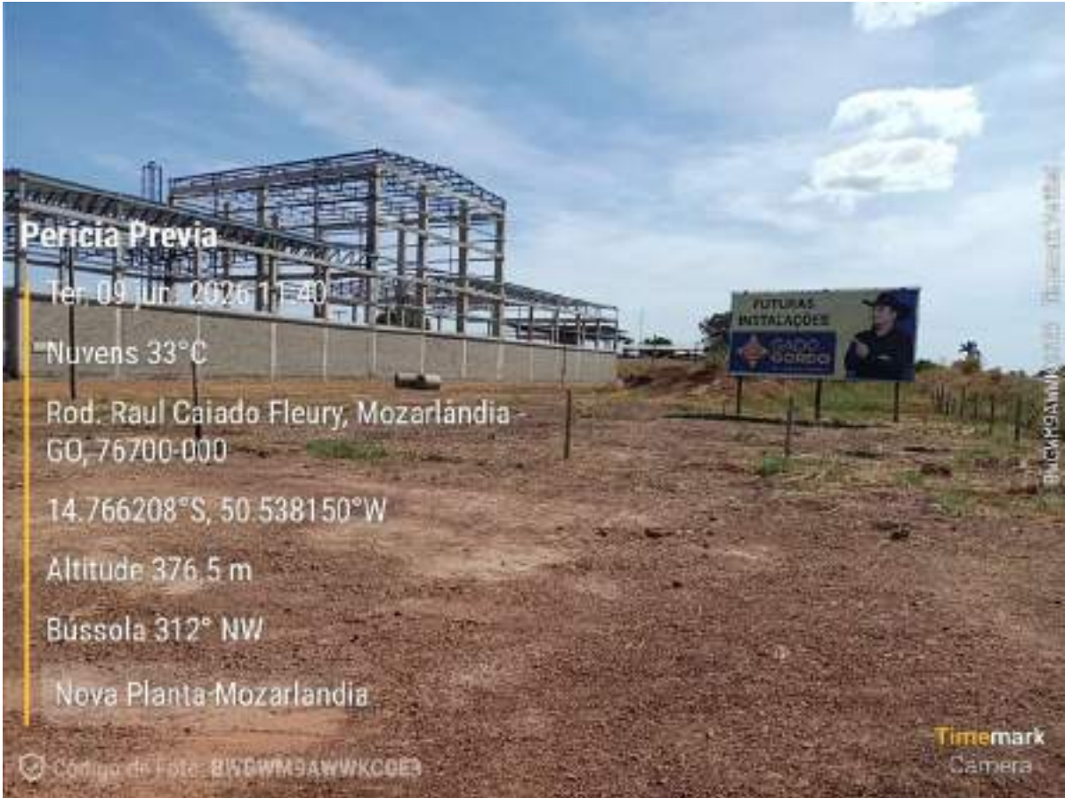
Foto 199 — Estrutura em construção — Nova Planta de Mozarlândia/GO. (registro da diligência, 09/06/2026).
