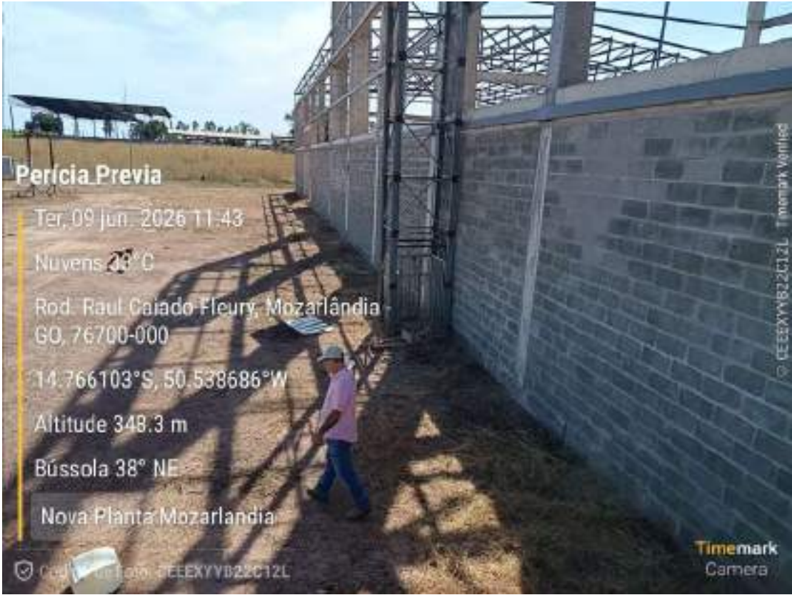
Foto 191 — Muro/estrutura da obra — Nova Planta de Mozarlândia/GO. (registro da diligência, 09/06/2026).
