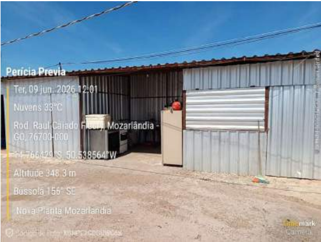
Foto 184 — Edificação/galpão metálico — Mozarlândia/GO. (registro da diligência, 09/06/2026).
