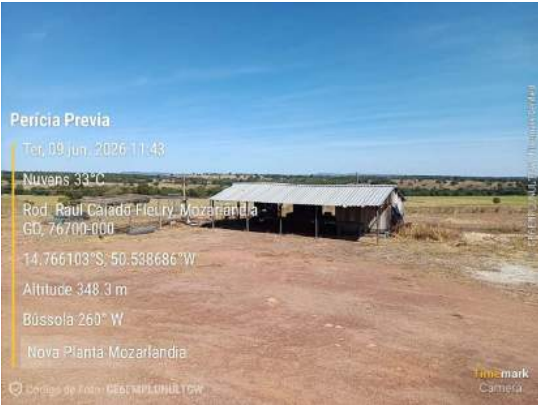
Foto 194 — Galpões e estruturas da obra — Nova Planta de Mozarlândia/GO. (registro da diligência, 09/06/2026).
