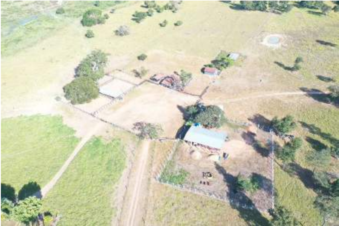
Foto 15 — Vista aérea (drone) — sede e benfeitorias, Fazenda Princesinha do Remansão. (registro da diligência, 09/06/2026).
