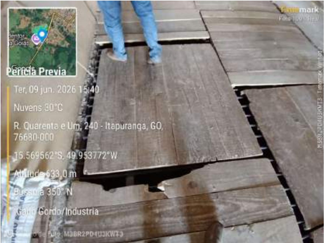
Foto 131 — Pavimento/moega de madeira — Gado Gordo Indústria, Itapuranga/GO. (registro da diligência, 09/06/2026).
