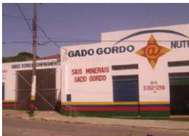
Limitações estruturais da indústria existente em Itapuranga/GO, instalada em perímetro urbano com restrições à expansão.
