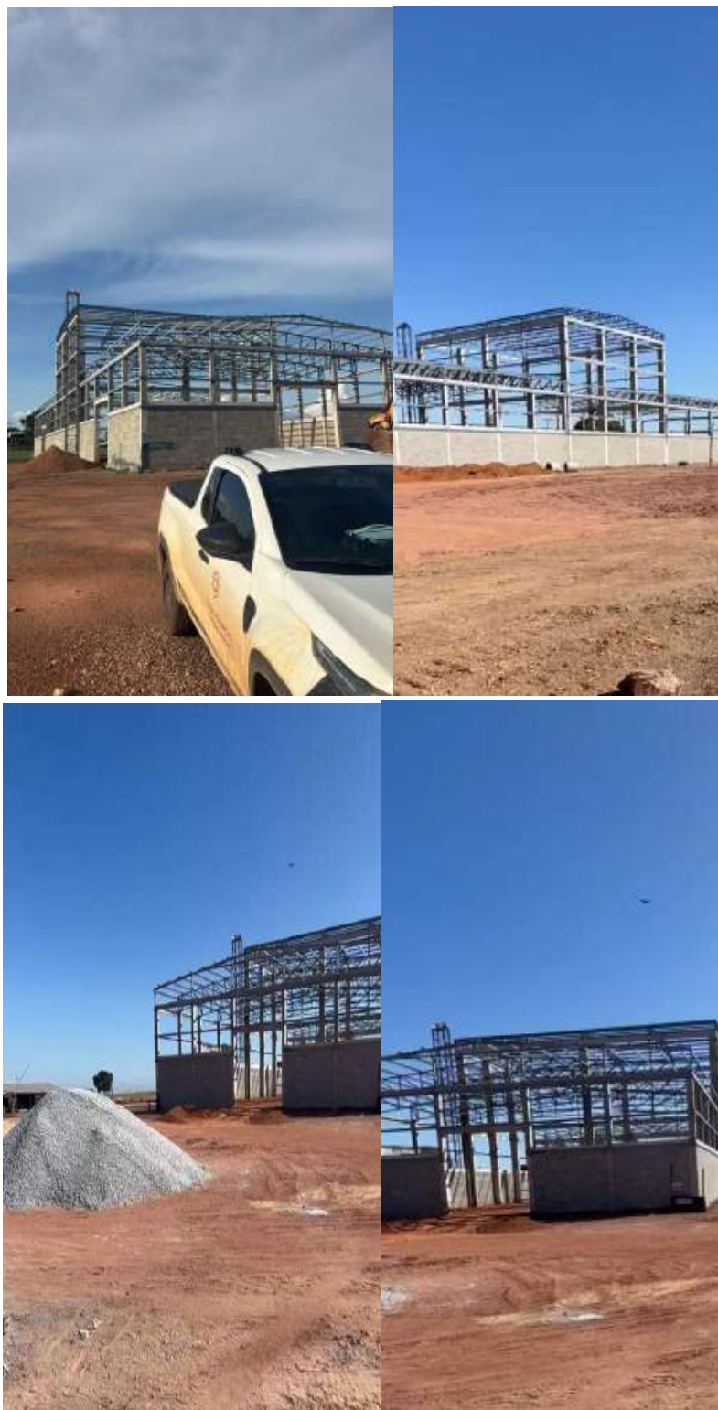
Andamento das obras da nova unidade industrial, posteriormente paralisadas em razão da retração do crédito rural.
